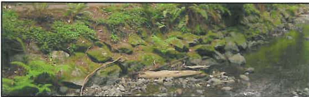
Riprap Strata Example
