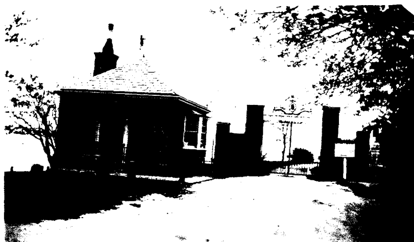
A.P.V.A. Toll House
