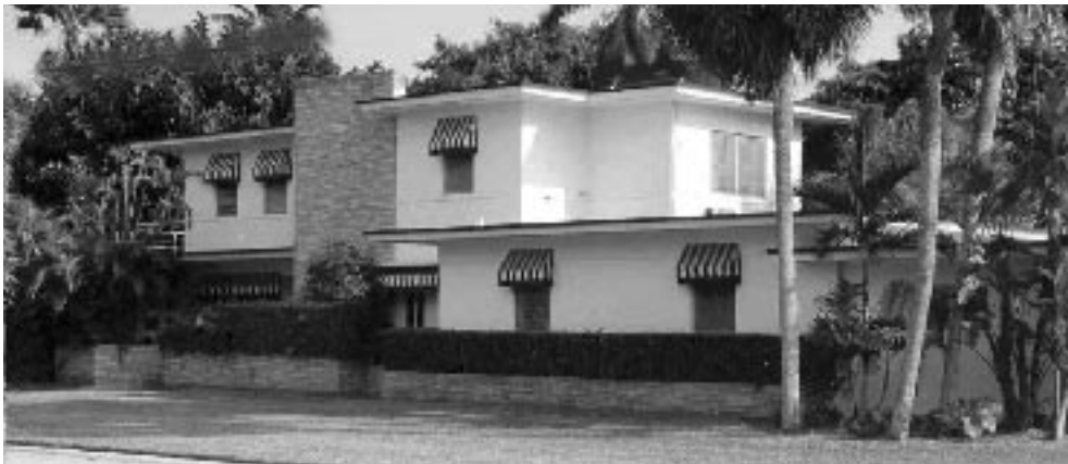
1136 N. North Lake, C. Moberg Arch., 1955
