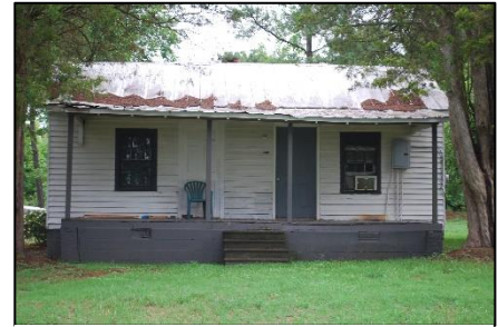
Photograph 25. Tenant House (WA8202)
