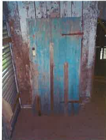
Door 5, historic door
