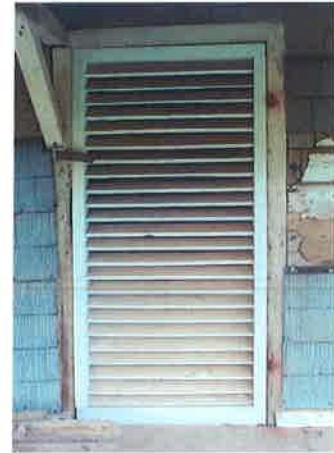
Door 5, temporary exterior door
