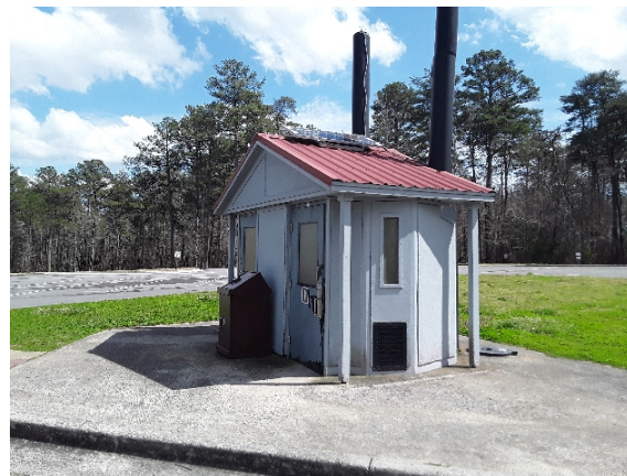
2022_LIRI_66404_Falls Comfort Station_Front.jpg
