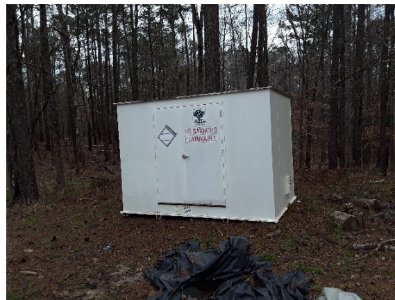
2021_HOBE_not found_HAZMAT storage 2_Front.jpg
