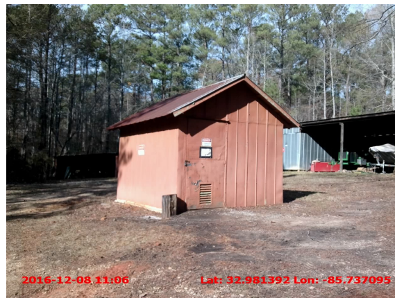
2016 HOBE_101802_HOBE Fuel Shed_Front.jpg
