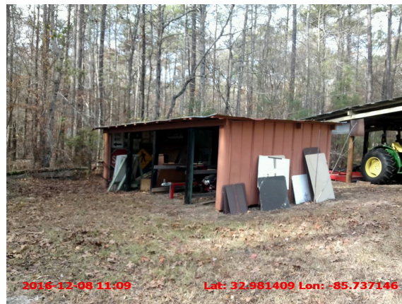
2016 HOBE_101805_HOBE Sign Shed_Front.jpg
