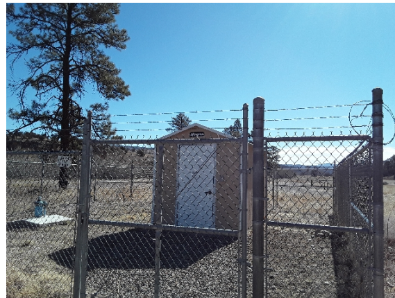
2021_GICL_246251_well house woody's _Front.jpg
