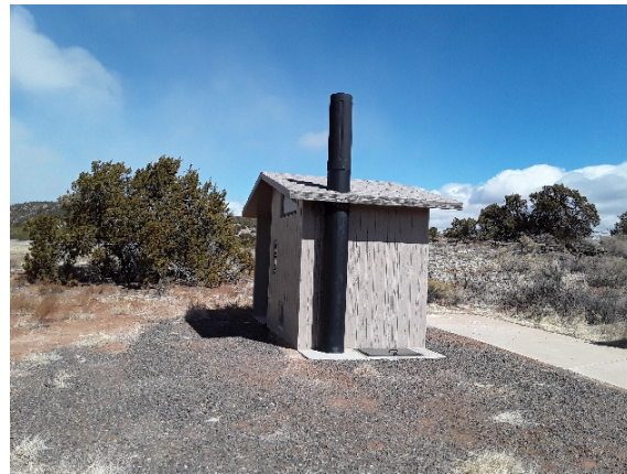
2021_ELMA_238186_FrontAT Vaulted Toilet_Front.jpg
