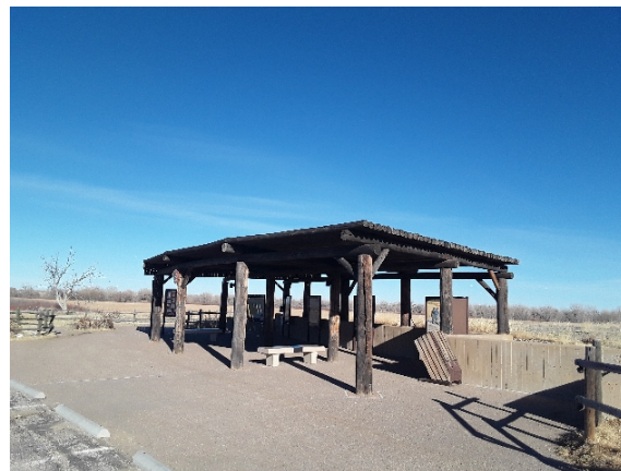
2021_BEOL_105449_Visitor Contact Station_Front.jpg
