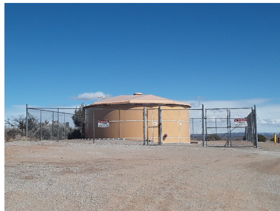
2020_HOVE_HOVE-Water Tank_Water Tank_Front.jpg
