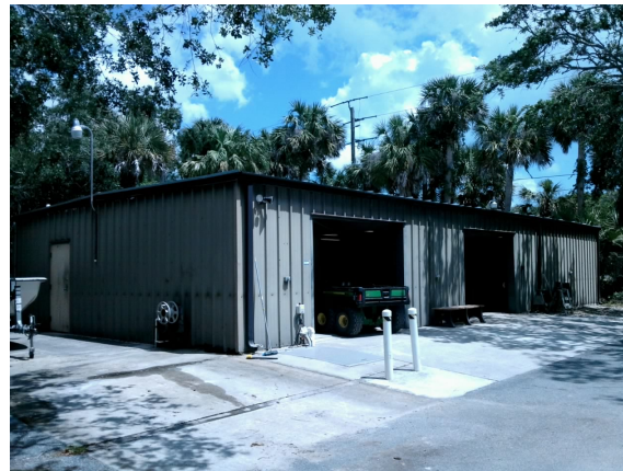
2017_CASA_37050_FOMA Maintenance Shop_Front.jpg
