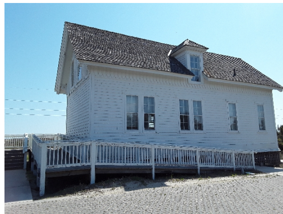
2021_CAHA_28913_BI HS Ranger Station_Front.jpg
