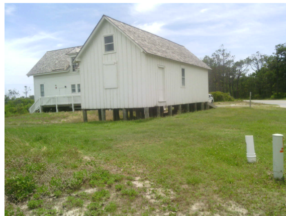
2016_CAHA__Garage of 28913_Front.jpg
