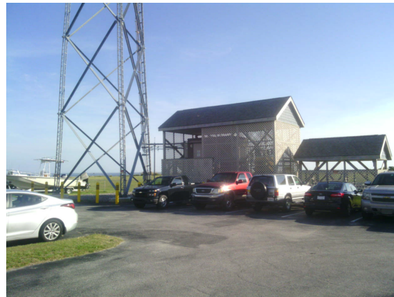
2016_CAHA__Oregon Inlet Radio Tower_Front.jpg
